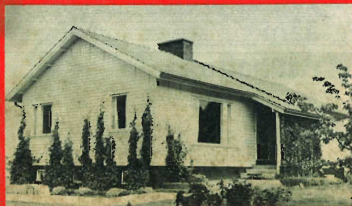
OMAKOTIRAKENTAJAN JÄLKIVIISAUTTA (n. 60)
